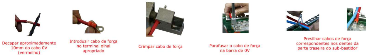
Figura 42b – Procedimento para instalação do cabo positivo de consumidor (terminal olhal).
