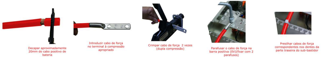
Figura 48a– Procedimento para instalação do cabo positivo de bateria (terminal à compressão).
