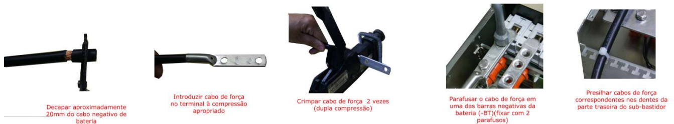
Figura 48b – Procedimento para instalação do cabo negativo de bateria (terminal à compressão).
